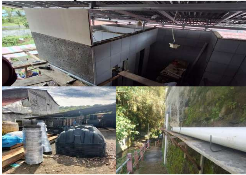
Gambar 3.15 Pembangunan IPAL Skala Pemukiman
